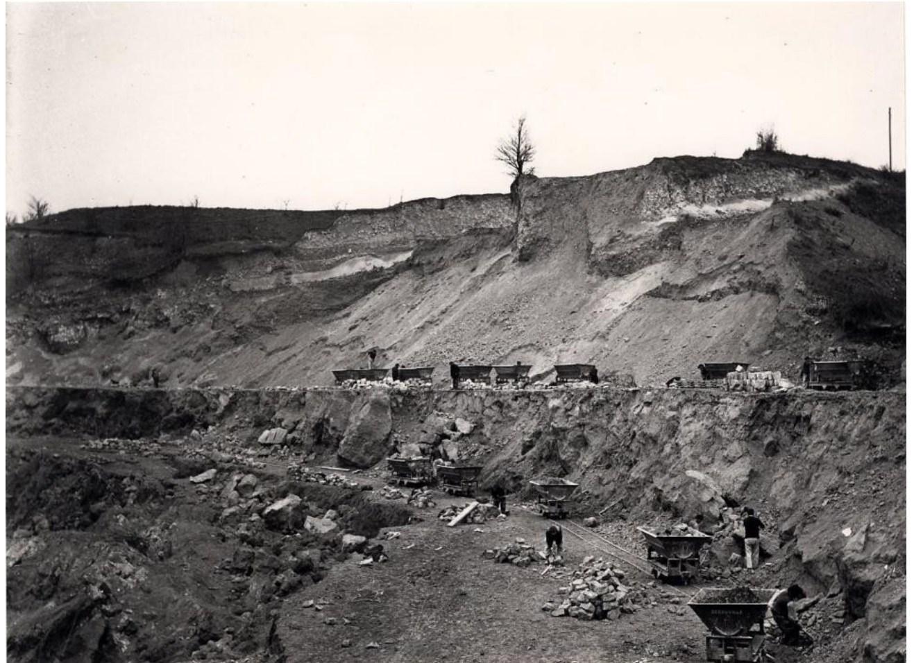
Carrière à ciel ouvert de Calcaire Grossier (Ivry-sur-Seine)
